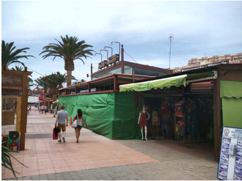
Foto 1. Ampliación no autorizada realizada recientemente.
